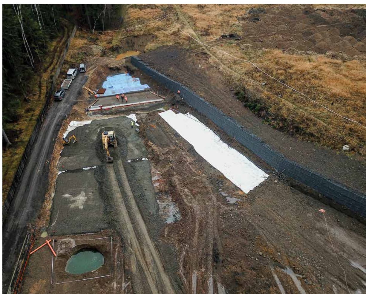
Pohled na staveniště na výsypce bývalého lomu Hájek
