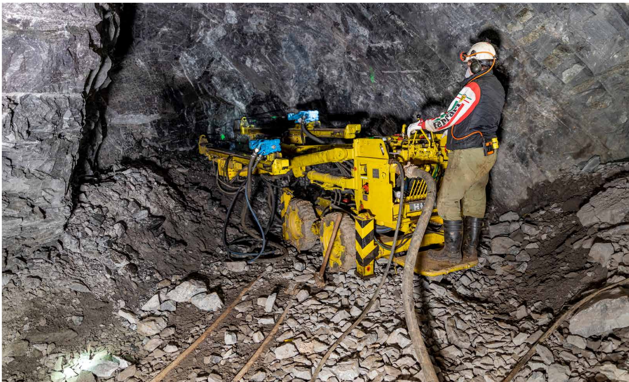
Ražba nové laboratorní chodby
