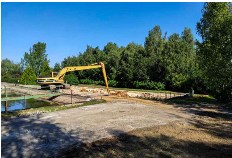
Čištění nádrže, bagrování vysrážených kalů ze sedimentačních nádrží vyčištěné důlní vody, ČDV Kutná Hora
