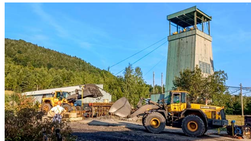
Likvidační práce v areálu Dolu Frenštát
