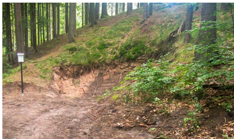
Situace před a po provedení zajišťovacích prací
