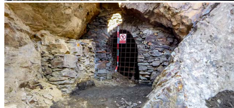
Práce na opravě zajištění štoly
