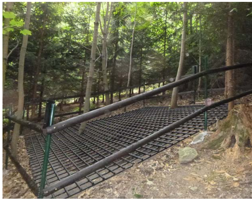
Překrytí vstupu kovovou sítí
