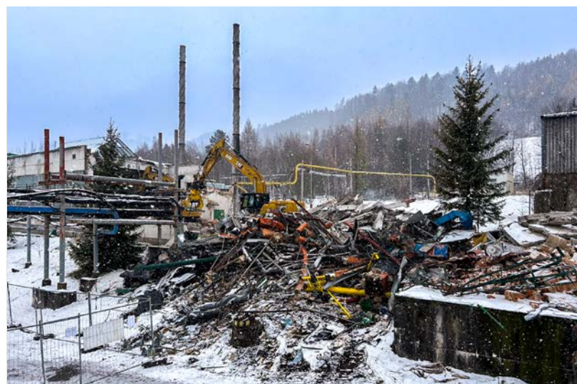
Bourání objektů v areálu Dolu Frenštát
