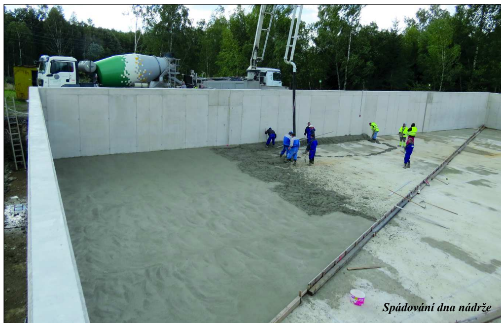
Bednění stěn nádrže
