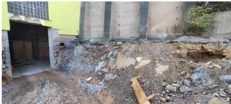
Stavební práce na Kaňku
