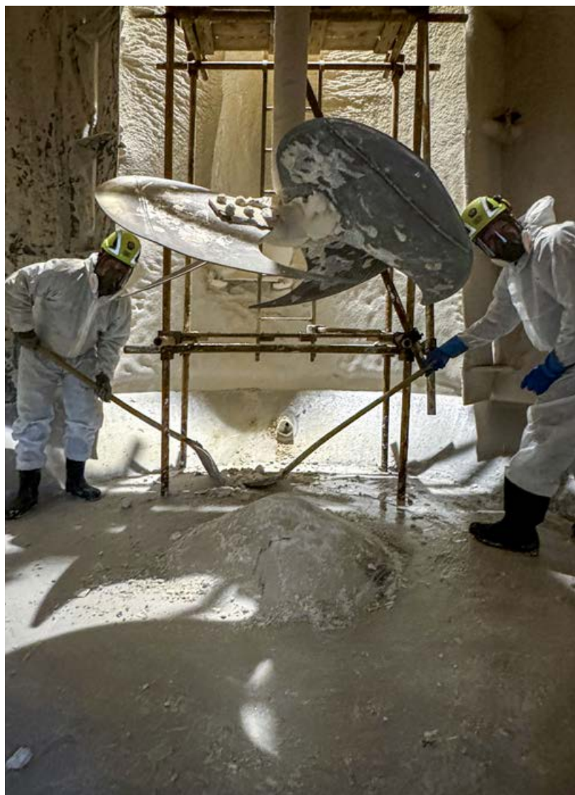
Báňští záchranáři při čištění technologických nádrží
