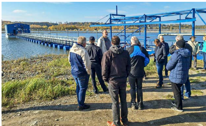
Workshop v areálu Chemické úpravy v Dolní Rožince
