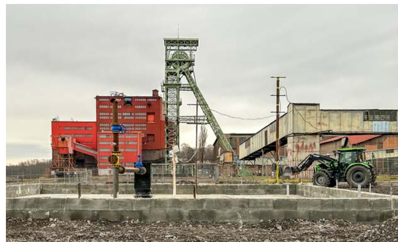
Areál Dolu Lazy před a po demolici skipové věže
