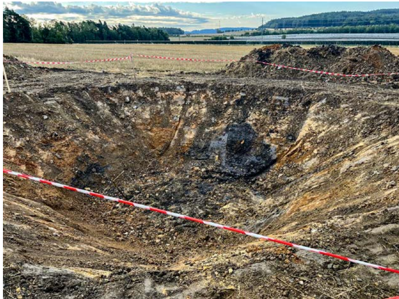
Zabezpečení propadu před jeho zásypem
