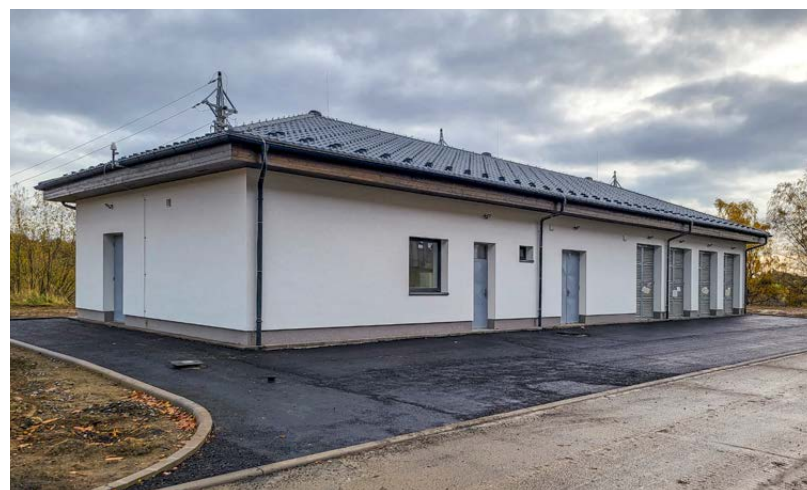
Nová rozvodna po dokončení
