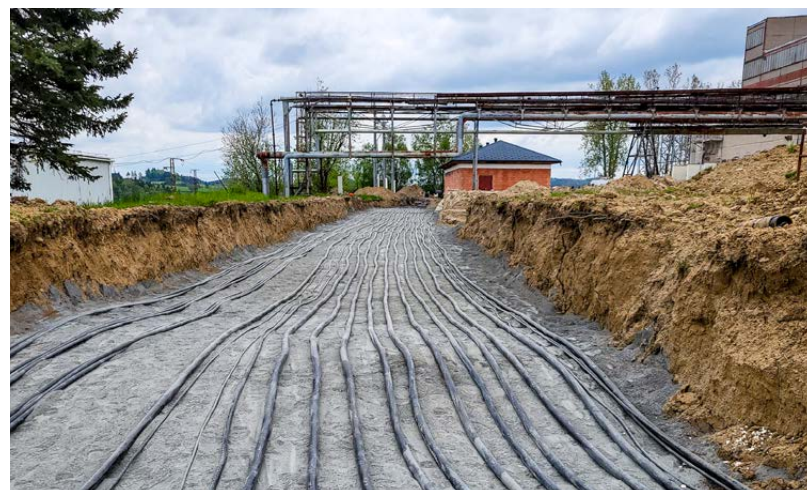
V průběhu stavby
