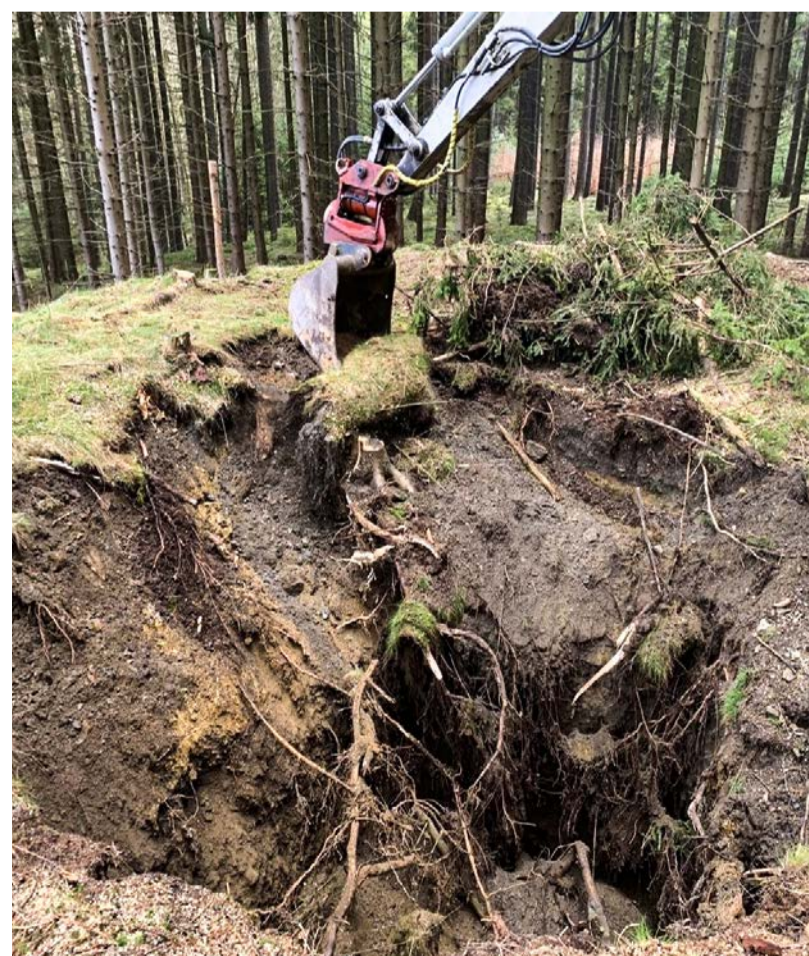
Práce na propadu v Drmouli
