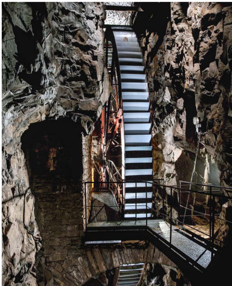
Vodní kolo s obnoveným nátěrem
