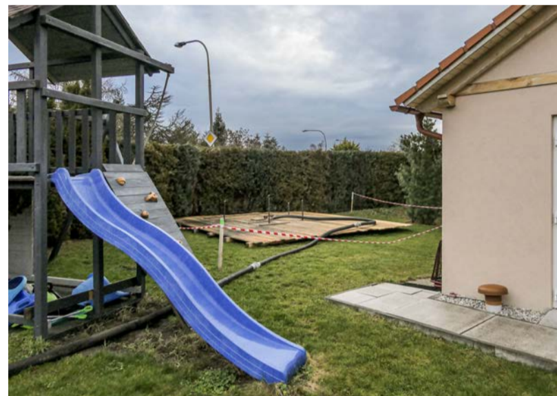
Propad na zahradě rodinného domu
