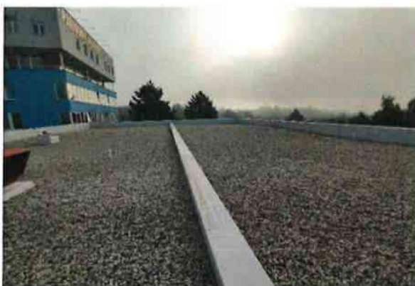
Střecha administrativní budovy po rekonstrukci
