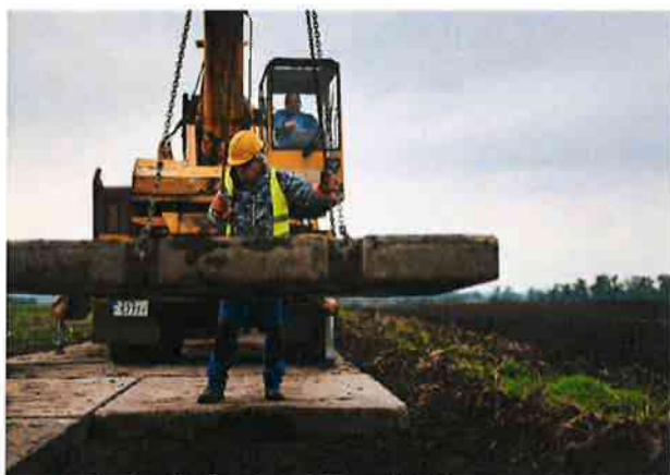
Sektor VIII, etapa III, pokládka panelové komunikace - sonda B13
