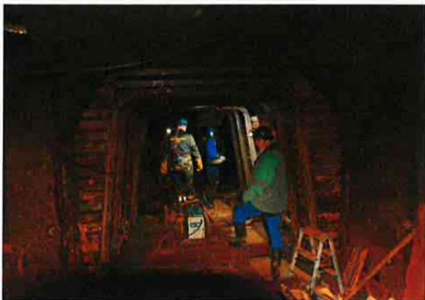
Statické zajištění štoly IDA
