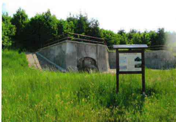
Oprava zdi u hlavní úpadní v Radvanicích
