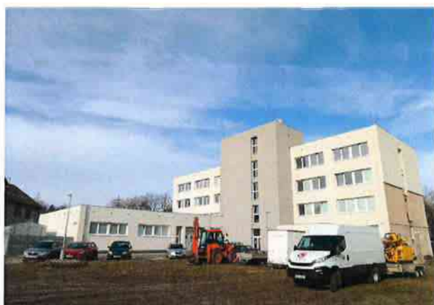
Práce na zateplení správní budovy - dokončení
