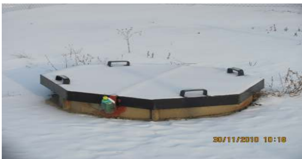
Obrázek č. 1-2: Zabezpečení vrtu TBCT-3
