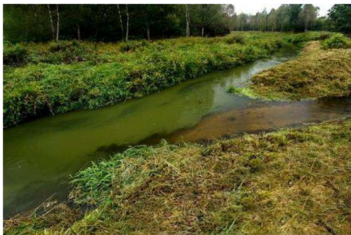
Obrázek č. 1-3: Výpustní profil č. 1 OKC-VS (vyústění obtokového kanálu do toku Ploučnice).
