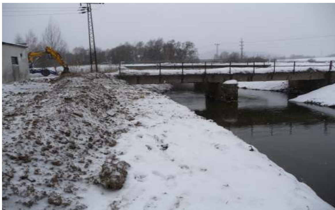
Obrázek č. 1-8: Koryto toku Ploučnice po odtěžení sedimentu, prosinec 2010
